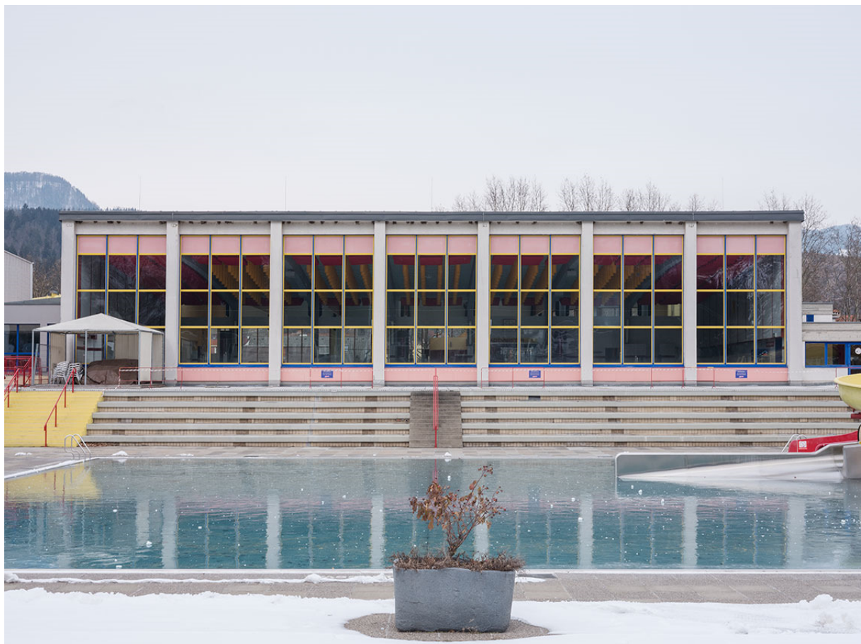
Hallen- und Freibad „Stadionbad“, Kapfenberg © Michael Goldgruber
