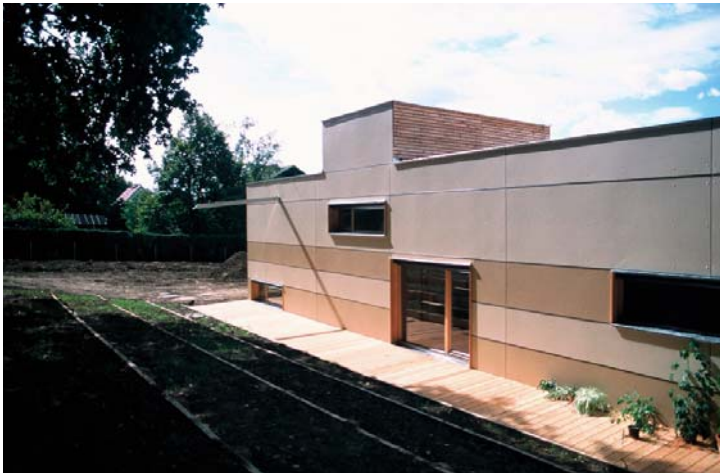
Kindergarten Bad Gleichenberg; Architektur: Siegfried Loos; Foto: © Siegfried Loos
