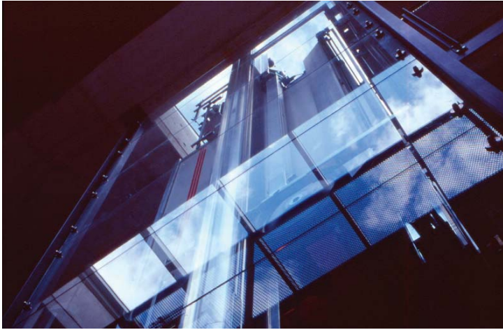
Tagesheimstätte Pischelsdorf; Architektur: Irmfried Windbichler; Foto: © Irmfried Windbichler
