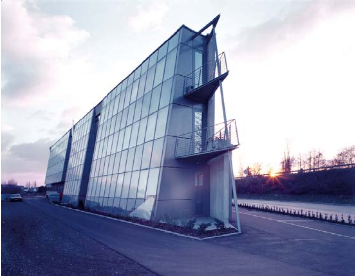
Bürogebäude Graz (Rennstall Dr. Marko); Architektur: Franz Eitzinger; Foto: © Peter Eder
